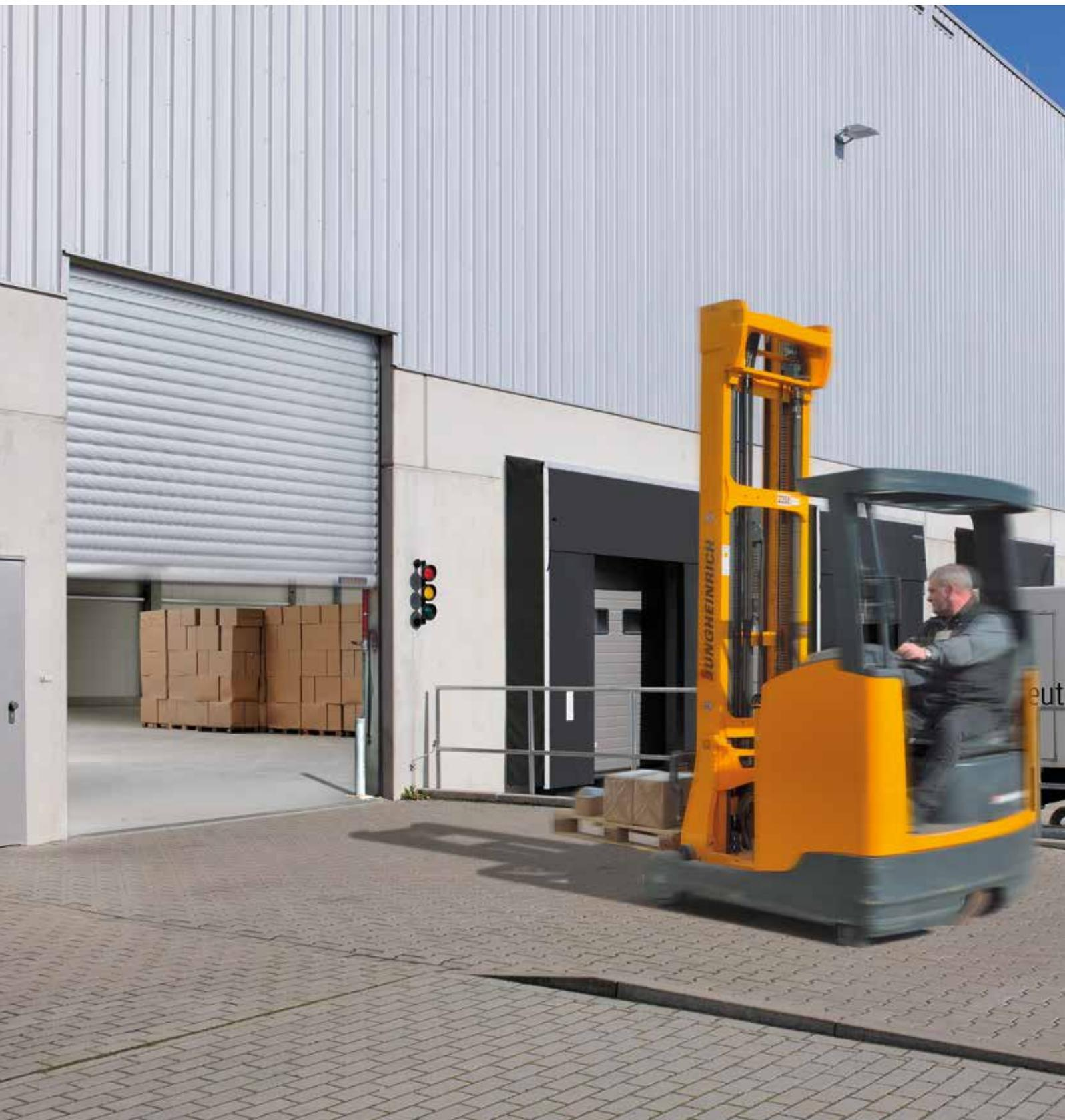
Rolovacia brána DD S6 presvedča rýchlym otváraním pre brány so šírkou do 7500 mm a výškou 8500 mm.
