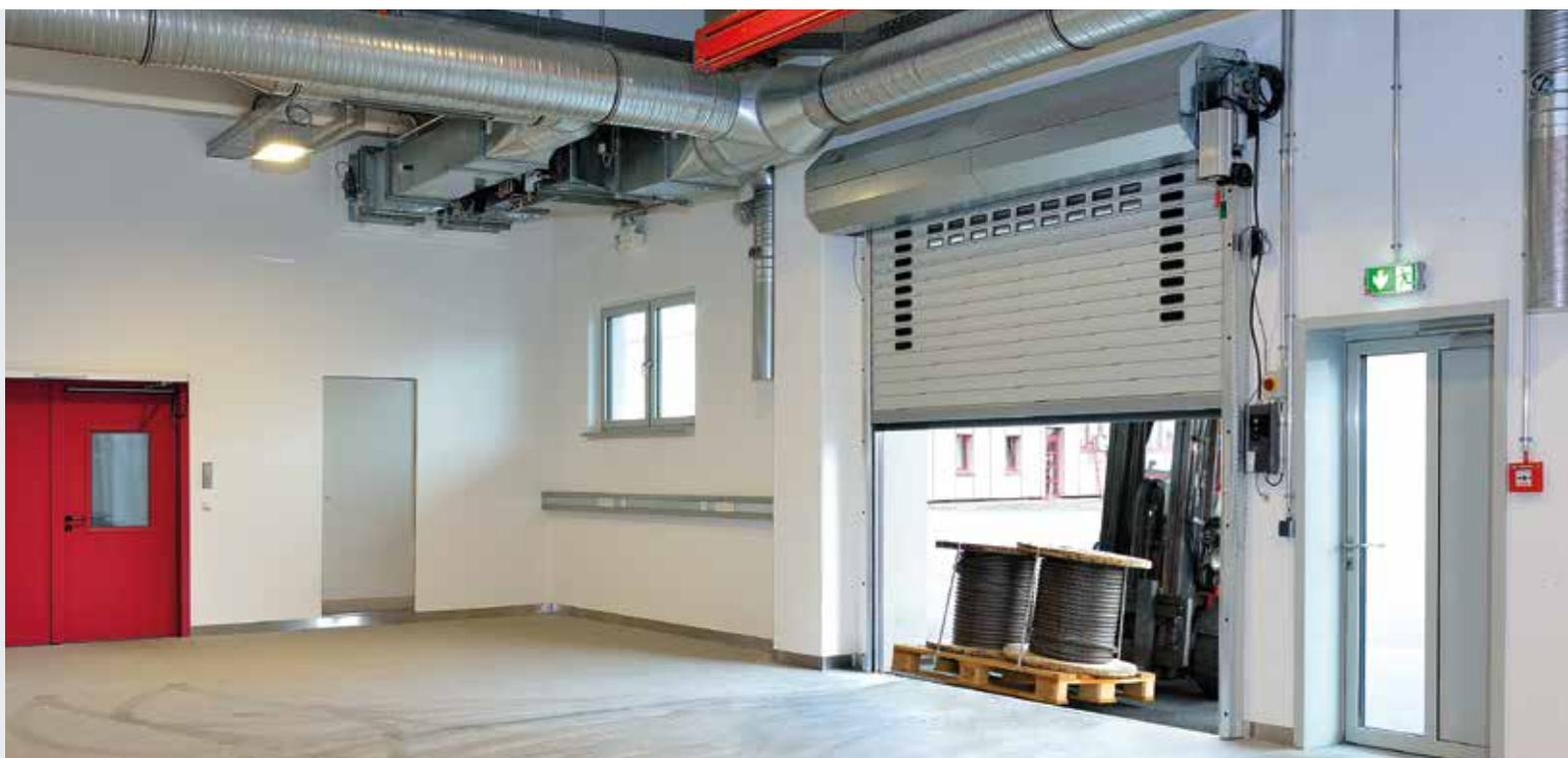
Vďaka vysokej rýchlosti otvárania a zatvárania až 1,1 m/s sa optimalizuje prevádzka a znižuje strata tepla.
